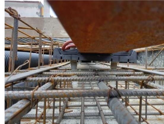
A estrutura foi totalmente projetada para suportar trilhos Grooved e Vignole, sendo os especificados para obra do VLT os modelos 54G1 e UIC60 respectivamente.
