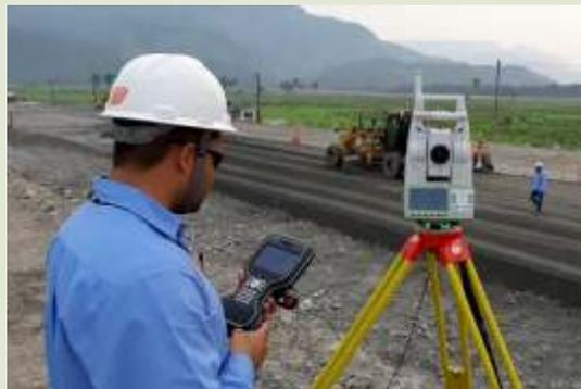
› **implantação de sistemas semiautônomos para nivelamento e geoposicionamento dos equipamentos de terraplanagem e pavimentação**
